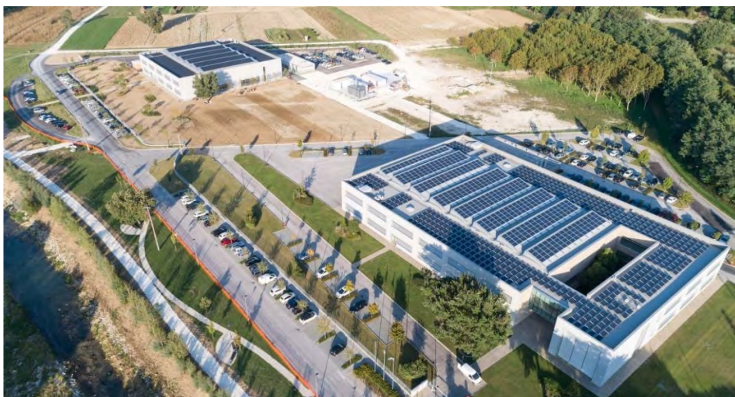
Figura 2. L6 (in alto a sinistra), L4 (in basso a destra) e impianto di cogenerazione (al centro)
