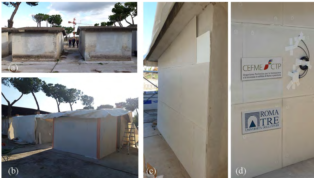
Figura 3. Immagine degli edifici analizzati (a), del caso studio (b), del sistema a cappotto in fase di installazione (c) e ad installazione terminata (d).
