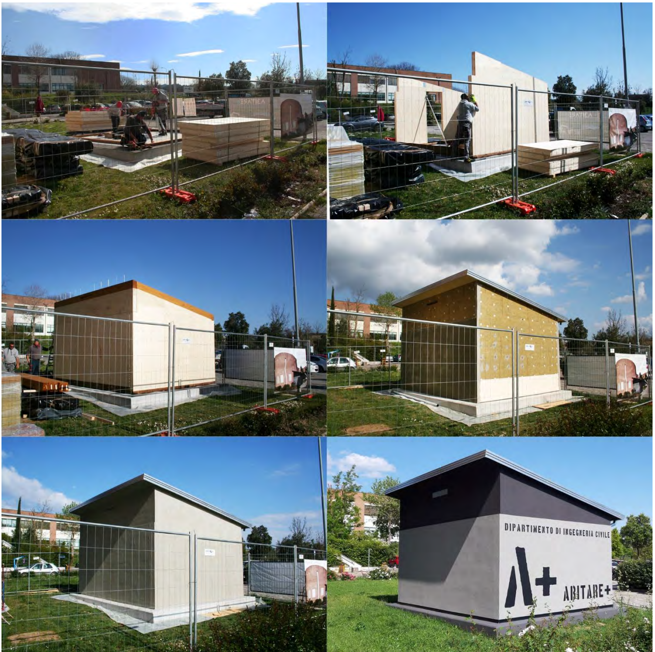
Figura 2. Varie fasi costruttive della test room.
